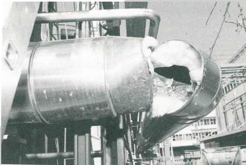
Abbildung 1: Zerstörter Bogen bei schießender Fahrweise [1]
